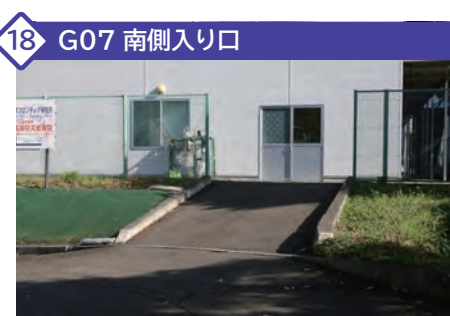
周辺に傾斜があることに加え、出入り口前に急なスロープが接続されています。
