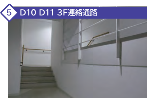
建物を接続する渡り廊下に階段があります。
