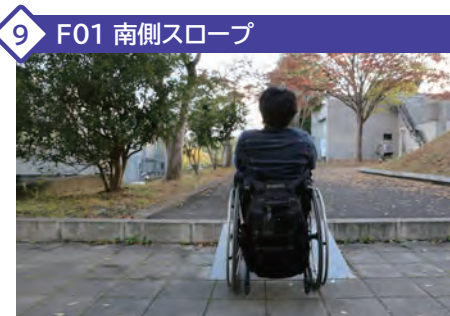
段差解消のスロープがありますが、通路幅が狭いため、転落に注意してください。
