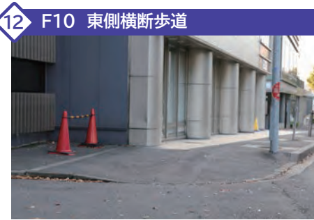
歩道の傾斜が急で、横に傾いているため、転倒に注意してください。
