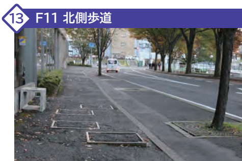
通路上にある排水溝の蓋と地面のひび割れにより、凹凸があるため、車椅子が操作しづらく注意が必要です。
