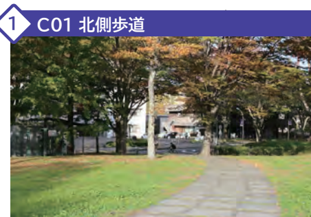
石畳の建物側は段が大きいため、転倒に注意してください。
