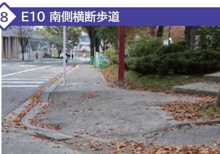
歩道の傾斜が急で、横の傾きと段差もあるため、転倒に注意してください。
