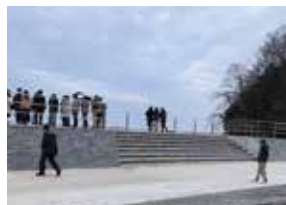
▲「雄勝石」が張られた防潮堤(波板地区)
