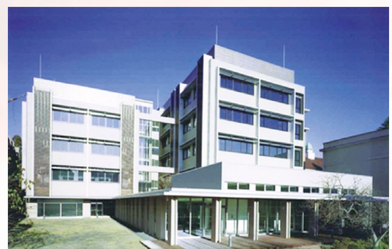
生命科学プロジェクト総合研究棟
