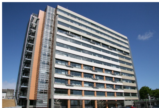
共創研究所を設置した 東北大学大学院工学研究科 総合研究棟
