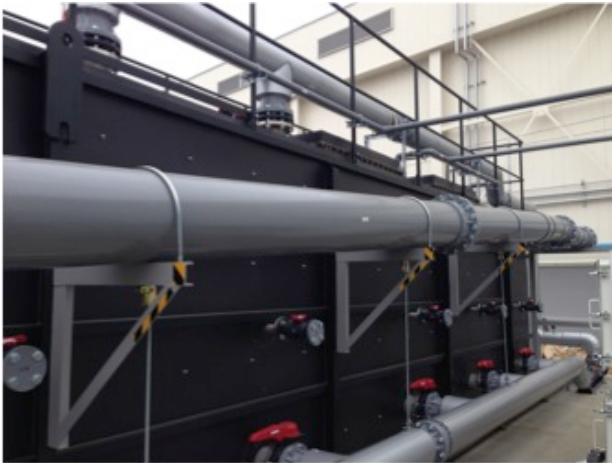
メタン発酵システムの写真(原料槽と発酵槽で 27 m 3 )
