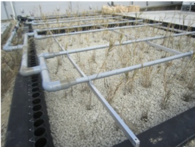
重層型人工湿地による排水処理
